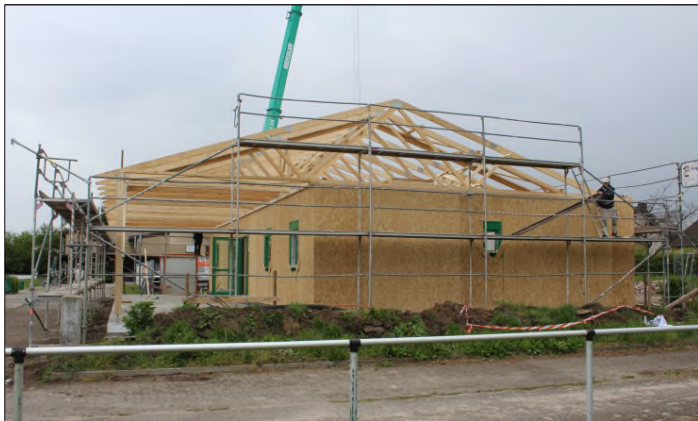
Baufortschritt beim Aufbau für das Jugendhaus / Mehrzweckgebäudes
